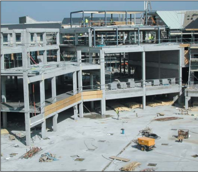
Precast Frame - Oran Precast Ltd.
